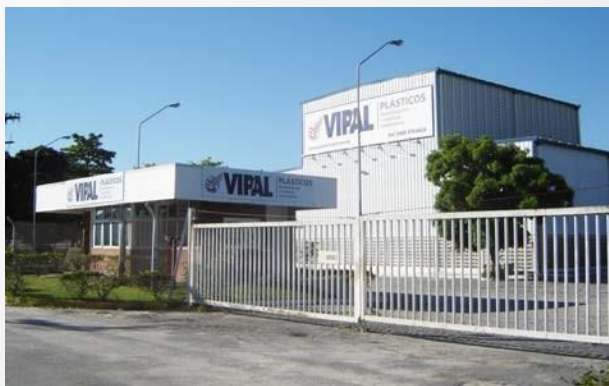
Fábrica Cabo de Santo Agostinho/PE
